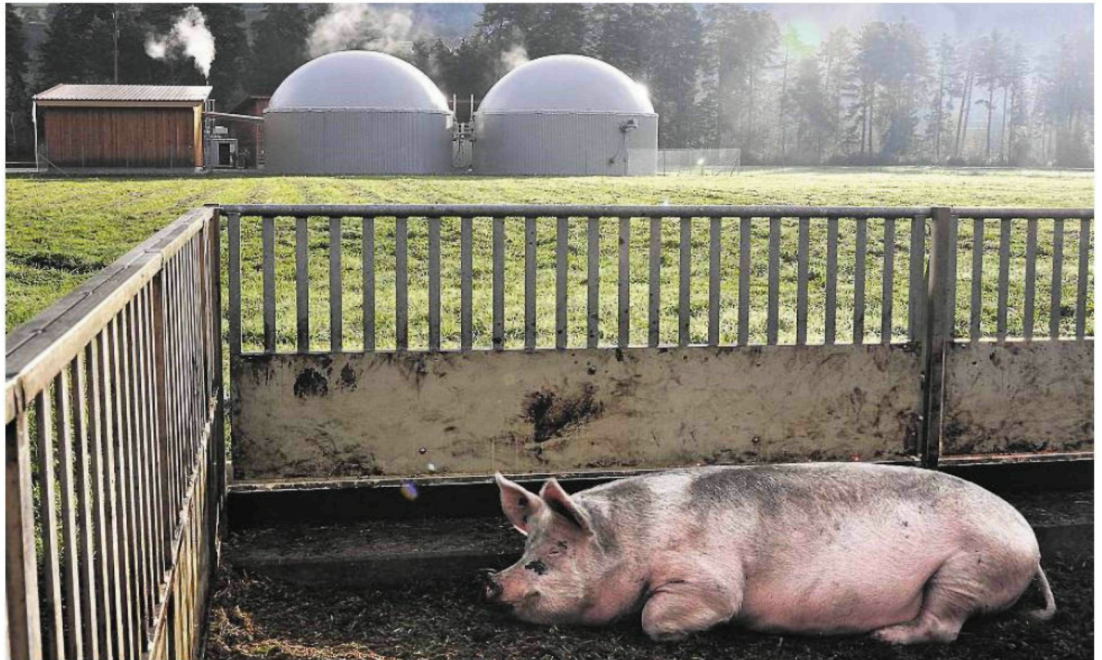
Strom und Wärme aus Mist und Gülle: Auch die Schweine auf dem nahen Gutsbetrieb der Anstalt Realta liefern einen Teil der Biomasse für die Cazner Biogas-Anlage (hinten). Bild Jano Felice Pajarola
